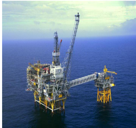
Illustrasjon 1: Heimdal med riserplattform til høyre
